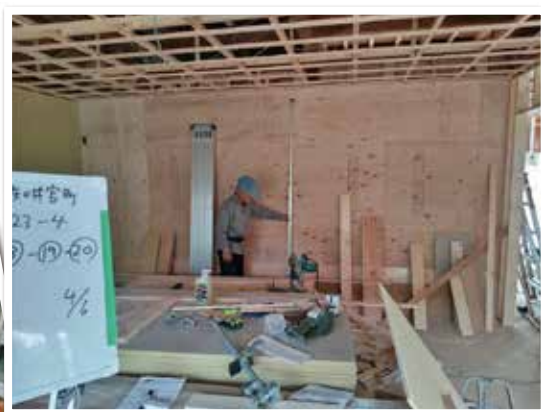
耐震補強工事の現場 安全な建物に
