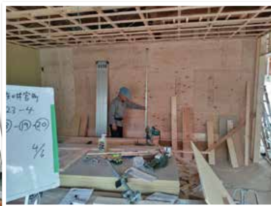
耐震補強工事の現場 安全な建物に
