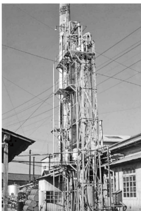
1957年建設 パイロットプラント
